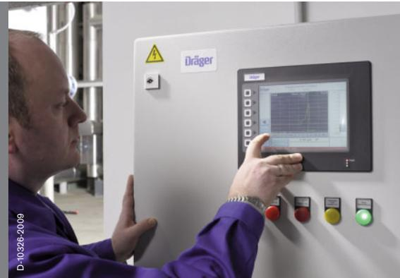
Dräger RVP 3900 позволяет визуализировать до 128 каналов от максимум восьми газообнаружительных систем Dräger REGARD 3900/3910. Сенсорная панель не требует конфигурирования, т.к. настраивается автоматически. Dräger RVP 3900 – это высокоэффективное и экономичное решение для визуализации, анализа и обобщения результатов измерений систем мониторинга газов.
